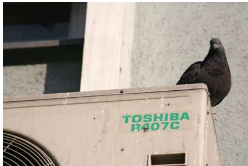
Verkotung von Klimaanlage
